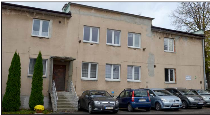
Budynek „F” Szpitala Specjalistycznego w Brzozowie
