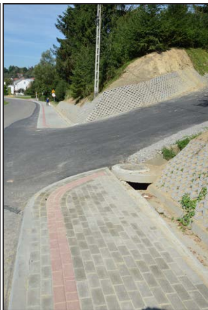
Chodnik i umocnienia skarp w Golcowej
