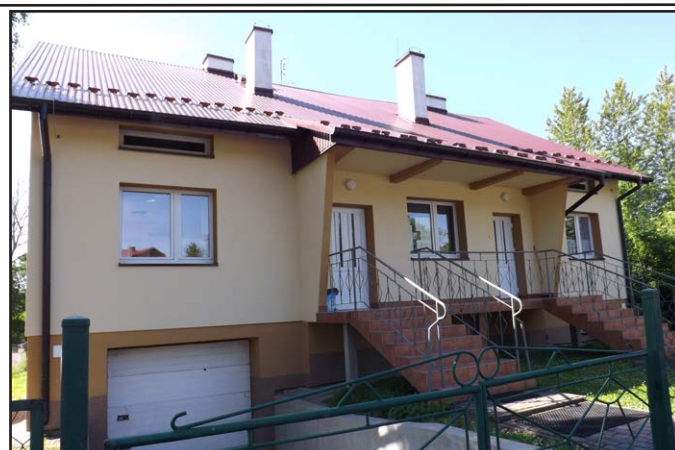
Ośrodek Zdrowia w Baryczy z nową elewacją
