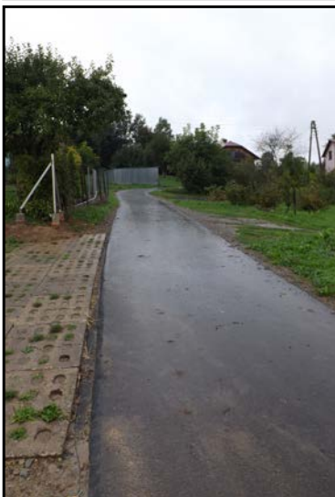
Nowa nawierzchnia na drodze w Golcowej
