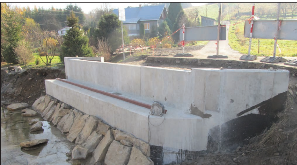
Most w Witryłowie w trakcie remontu
