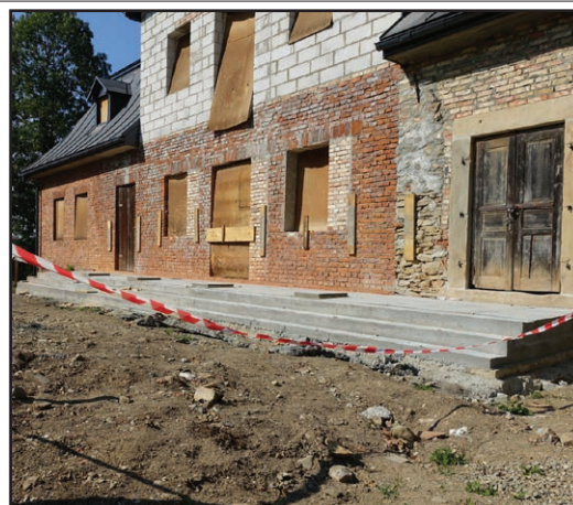
Remont dworu w Haczowie
