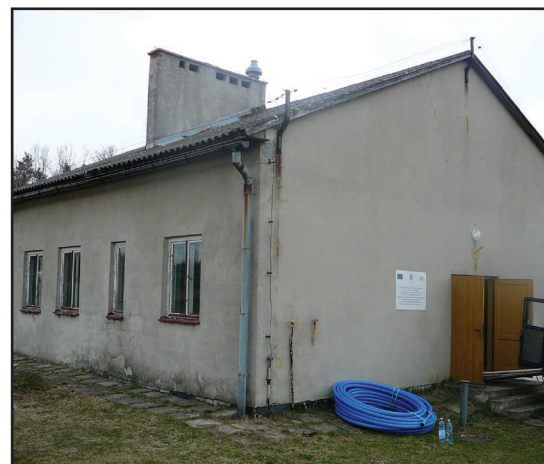
Budynek Stacji Uzdatnia Wody w Wesolej i jego otoczenie poddane zostaną kapitalnemu remontowi
