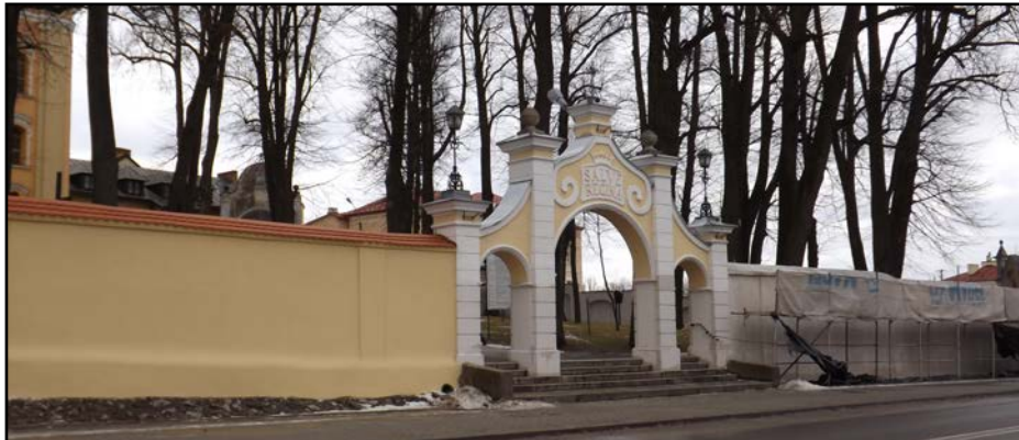
Prace restauracyjne nie ominęły również murów otaczających kościół
