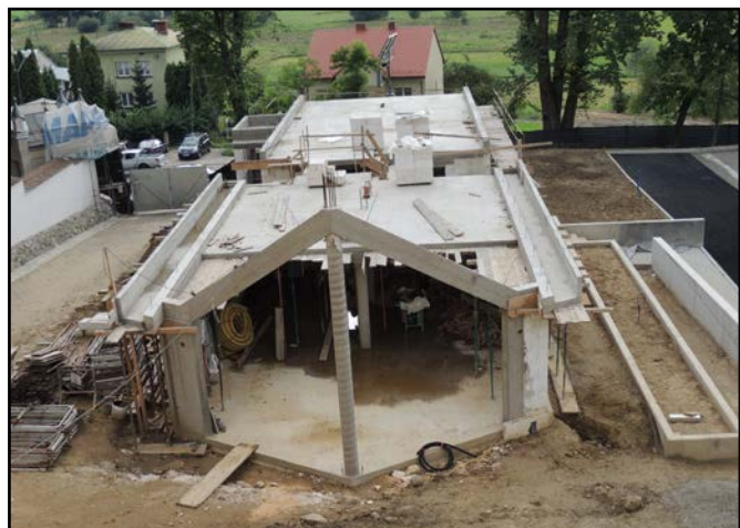
W budynku centrum pielgrzymkowo-turystycznego można będzie uzyskać potrzebne informacje
