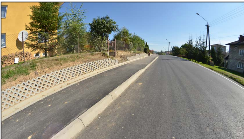
Na odcinku 720 metrów wybudowano również nowy chodnik
