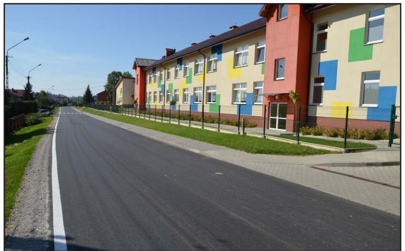
Wyremontowana droga powiatowa Brzozów - Wara w miejscowości Przysietnica
