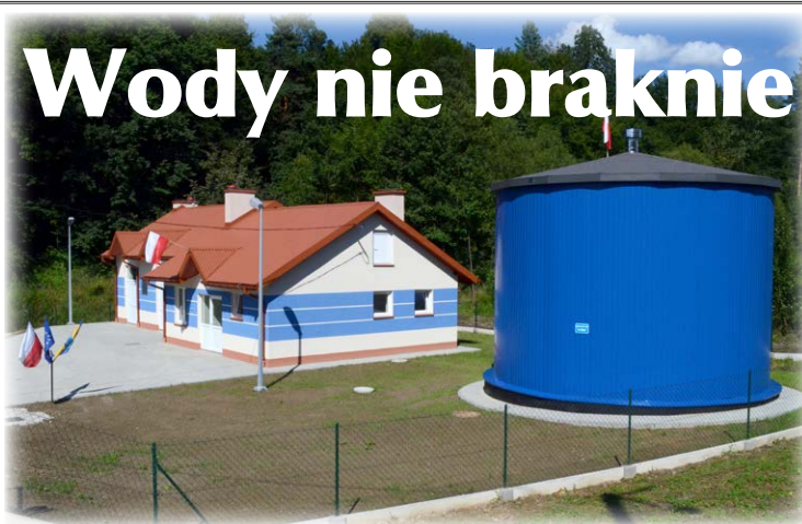
Stacja uzdatniania wody w Golcowej
