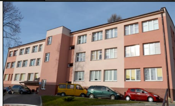
Termomodernizacja budynku przychodni
