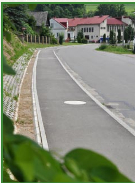
Nowy chodnik w Izdebkach przy drodze powiatowej Brzozów-Wara
