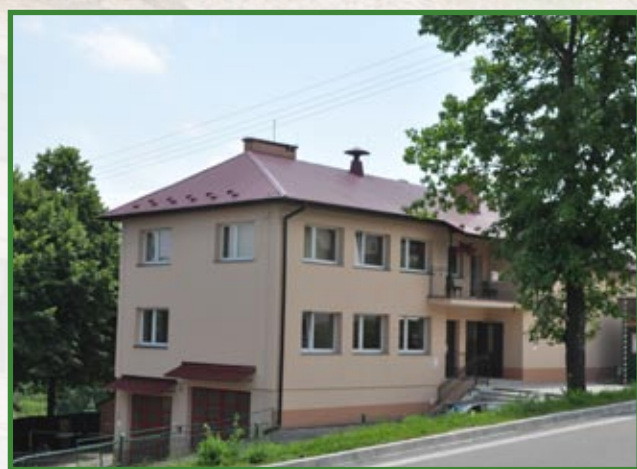
Wyremontowany budynek Domu Ludowego w Baryczy
