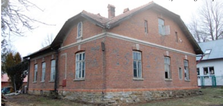
Po gruntownym remoncie budynek dawnej ochronki nadal będzie służył dzieciom
