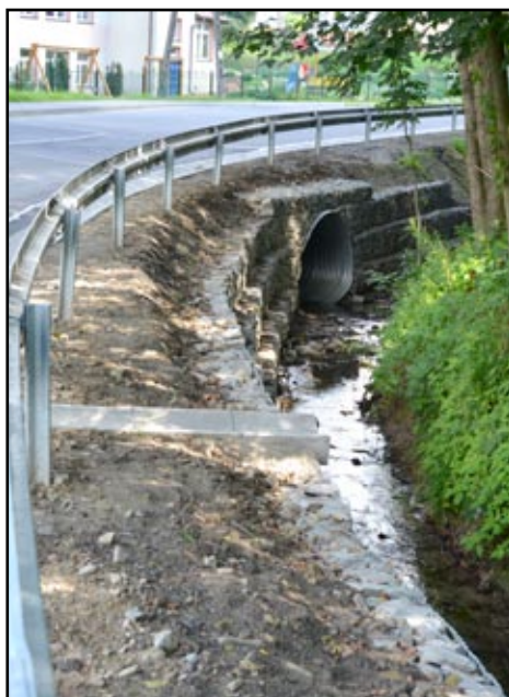
Przebudowany przepust drogowy w ciągu drogi powiatowej Jabłonica Polska-Jasionów w miejscowości Malinówka
