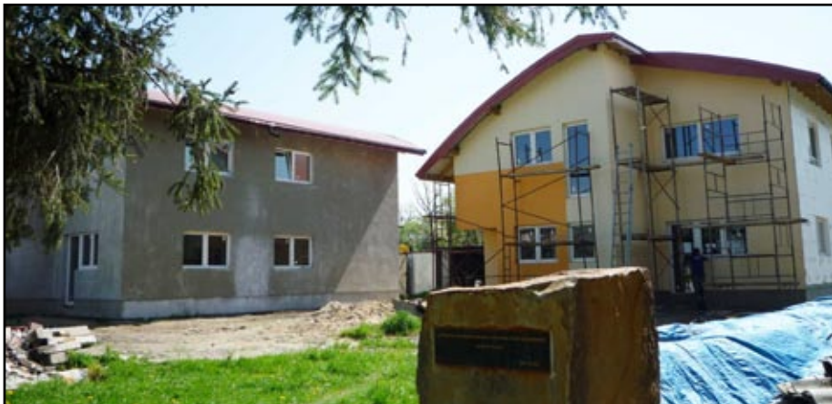
Postępują prace przy budowie Wioski Dziecięcej
