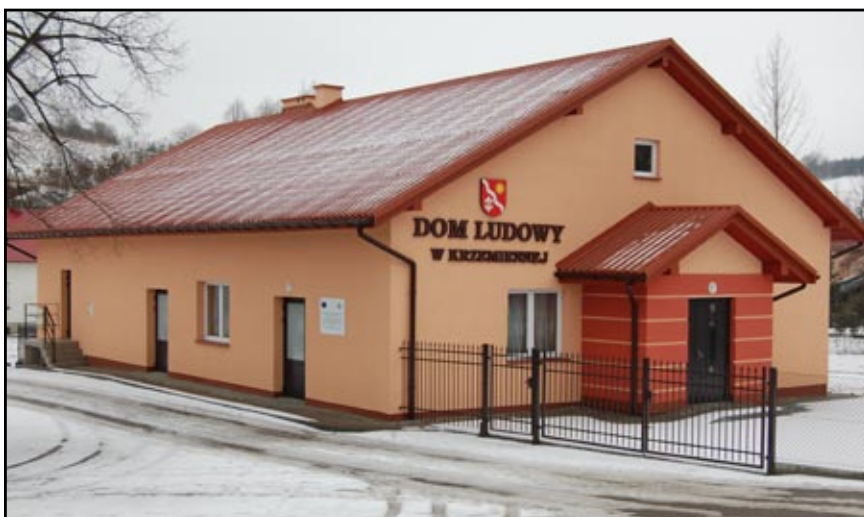
Dom Ludowy w Krzemiennej doczekał się generalnego remontu
