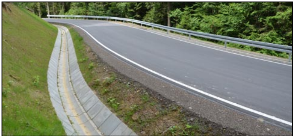
Zabezpieczone osuwiska przy drodze powiatowej Brzozów - Wara
