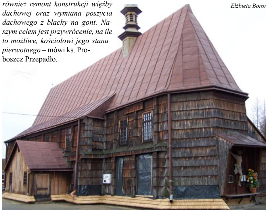
Pierwszy etap prac remontowych zakończono, zakres prac przewidziany na drugi etap zależny będzie od zebranych środków finansowych
