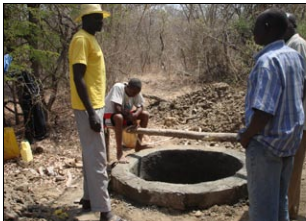
Nowa studnia. Zlokalizowano ją 30 m poza terenem ogrodzenia Centrum
