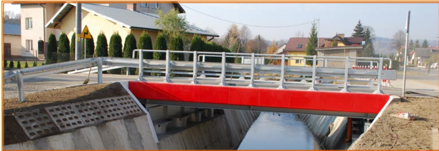
Wyremontowany most w Jasienicy Rosielnej
