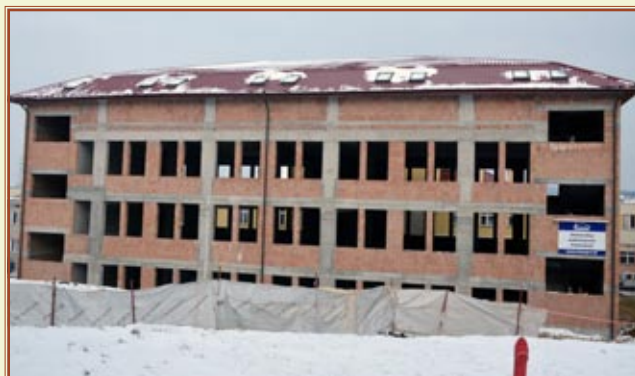
Przebudowa budynku Hotelowca - drugi etap
