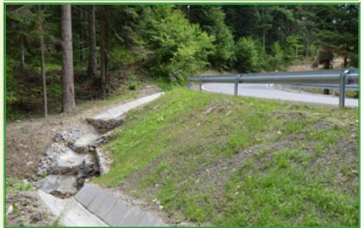
Zabezpieczone osuwiska na drodze powiatowej Brzozów - Wara w miejscowości Przysietnica
