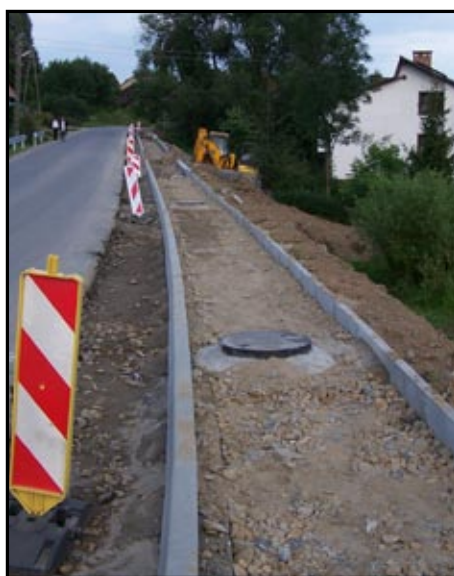
Wzdłuż drogi powiatowej Domaradz – Przysietnica powstaje nowy chodnik
