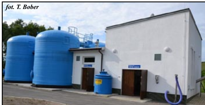
Oddana w tym roku do użytku oczyszczalnia ścieków w Domaradzu w znacznym stopniu wspomogła ochronę środowiska na terenie gminy
