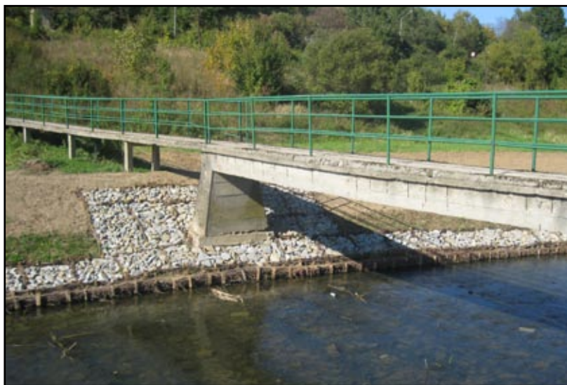
Wzmocnione brzegi i dno Stobnicy nie stanowią już zagrożenia dla kładki
