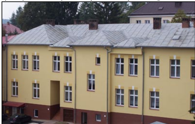
Nowa elewacja na budynku ZSE
