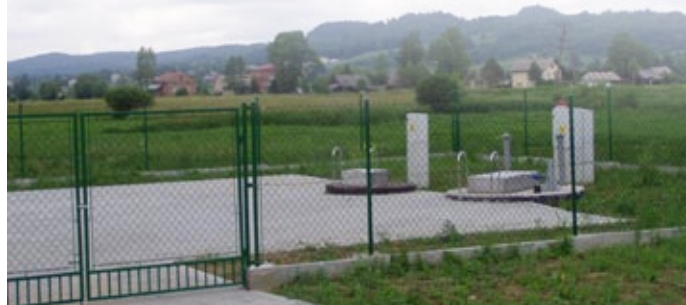
Docelowa przepompownia ścieków dla Starej Wsi
