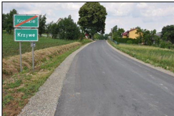
Droga po remoncie
