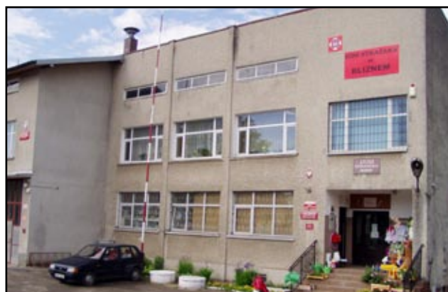
Dom Strażaka w Bliznem jeszcze przed remontem
