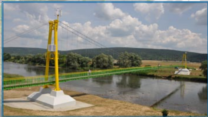
Nowa kładka na rzece San w Witryłowie
