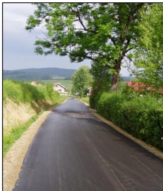
Remontowany odcinek drogi
