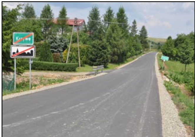
Wyboje, koleiny i inne niedoskonałości to już przeszłość...
