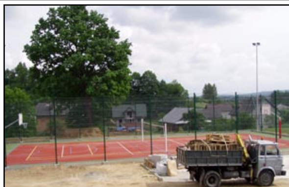
Końcowe prace porządkowe wokół Orlika przy ZS w Bliznem
