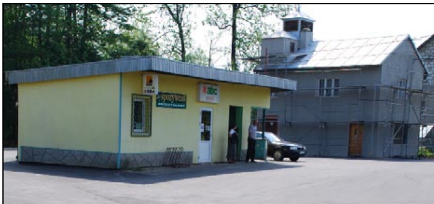
Przed biblioteką w Jabłonicy Polskiej wykonany został plac manewrowy dla samochodów
