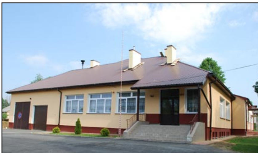
Prace przy Domu Ludowym w Malinówce
