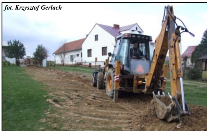
Prace przy budowie przykanalików
