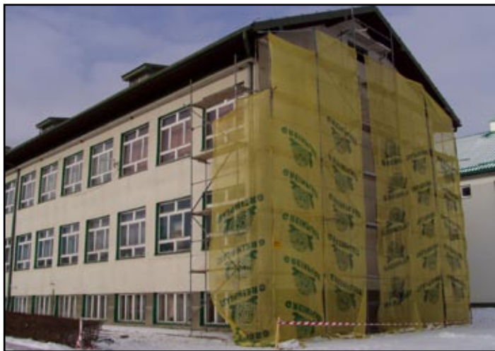
W ZS w Hłudnie trwa docieplanie zewnętrznych ścian budynku
