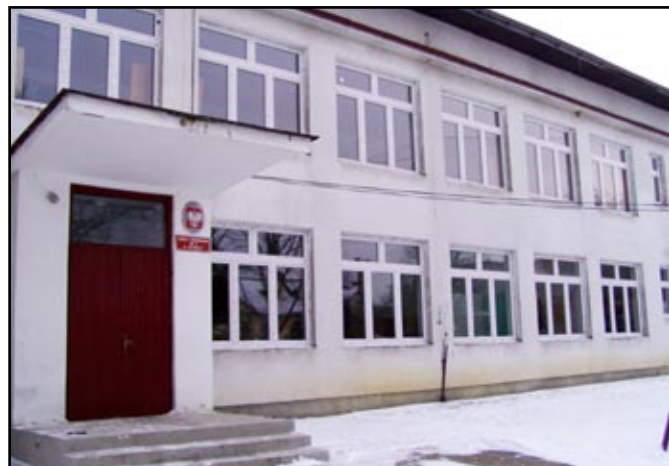
W SP Nr 2 w Wesołej wymieniona już została stolarka okienna
