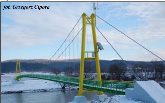
Nowo odbudowana kładka nad rzeką San
