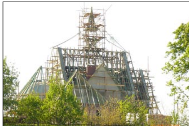
Budowa nowego kościoła
