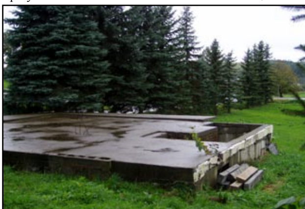
Fundamenty pod budynek przy blizneńskim cmentarzu
