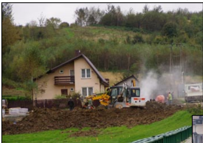
Prace budowlane przy stadionie ...
