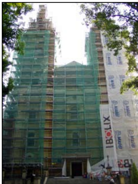
Prace remontowe prowadzone na frontonie świątyni
