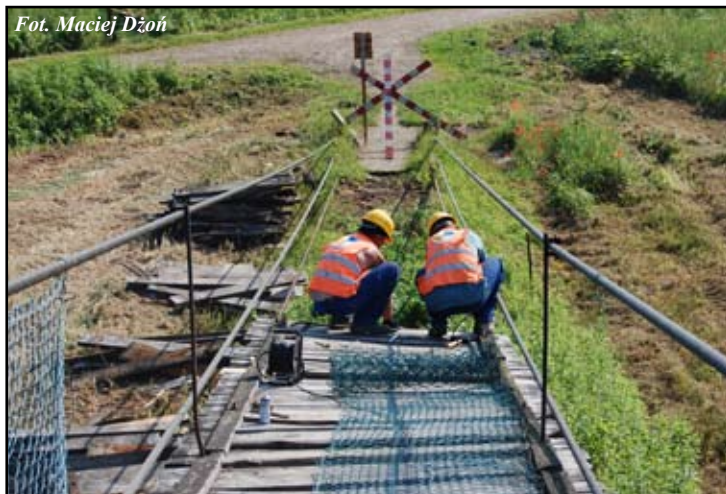
Prace rozbiórkowe prowadzone na nadsańskiej kładce
