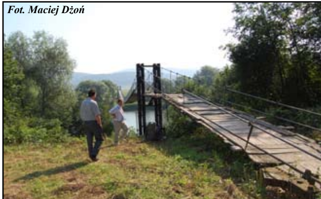
Stara, wysłużona kładka zostanie rozebrana. Zastąpi ją nowa, bardziej komfortowa
