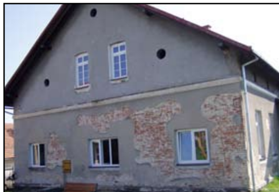
Po remoncie przedszkole w Bliznem zyska nową elewację
