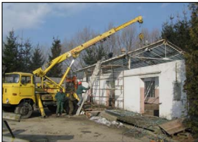
Rozpoczęto pierwsze prace związane z budową sieci kanalizacyjnej w Domaradzu oraz budową oczyszczalni ścieków
