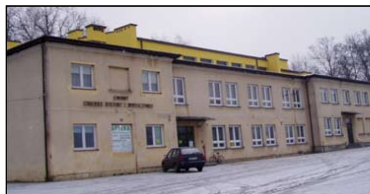
GOKiW w Haczowie zyskał nowe pokrycie dachowe
