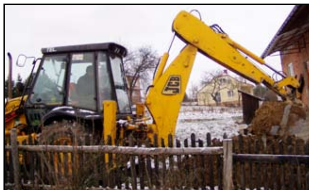
Prace przy budowie sieci kanalizacyjnej w Dydni
