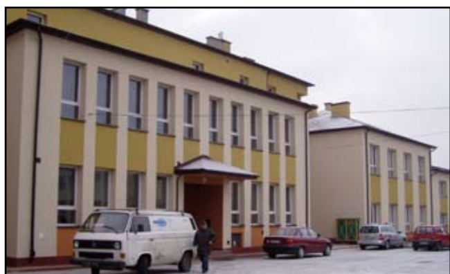
Na części budynku SP w Haczowie wykonano elewację
