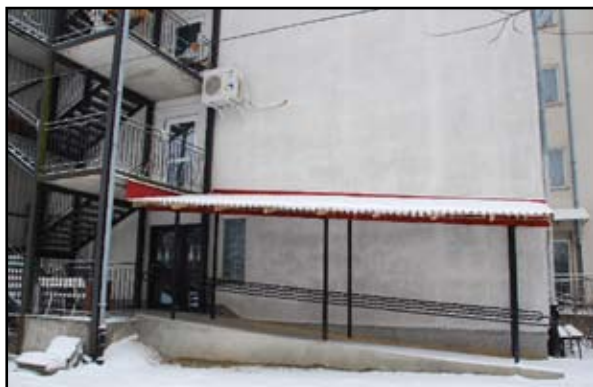
Podjazd dla wózków przy klatce ewakuacyjnej
