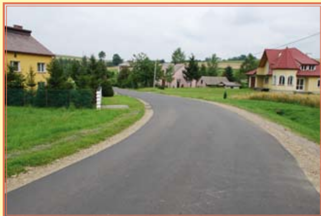
Nowa nawierzchnia na drodze w Izdebkach - Rudawcu
