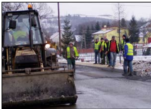
Prace przy budowie chodnika w Niebocku
