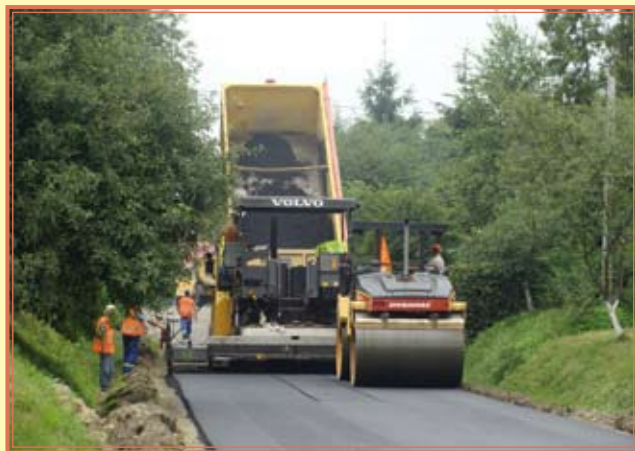
Prace remontowe na drodze Humniska - Górkach
