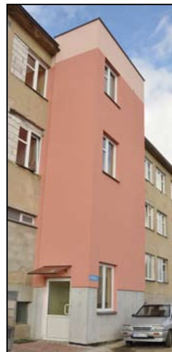
Szyb windy w budynku przychodni
