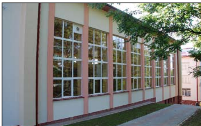
Nowa elewacja na sali gimnastycznej w ZSB
