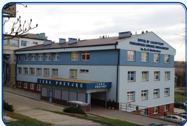
Rozbudowa Izby Przyjęć Szpitala Specjalistycznego
