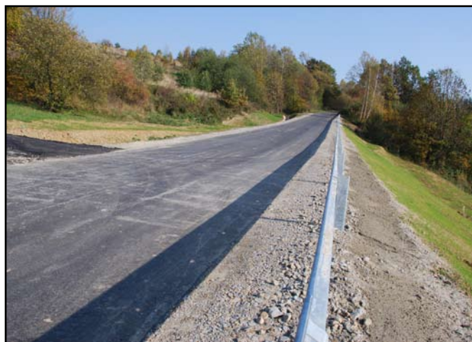
Zabezpieczone osuwisko na drodze Blizne-Golcowa w Bliznem
