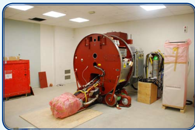
Nowy akcelerator w trakcie montażu
