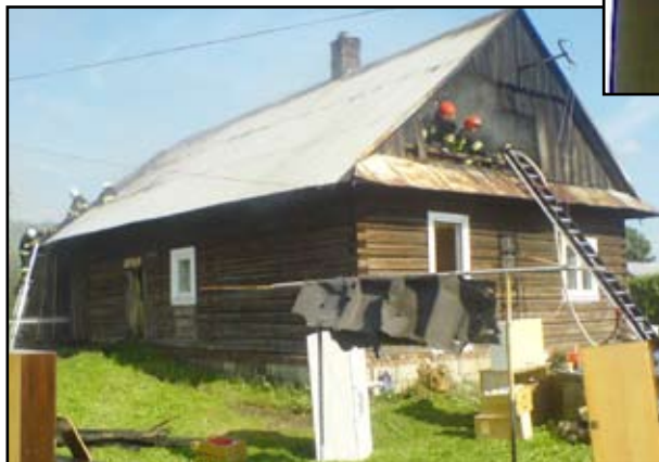
... do częściowej rozbiórki konstrukcji dachu
