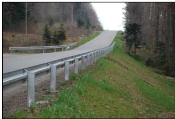
Zlikwidowane osuwisko na drodze Brzozów - Zmiennica
