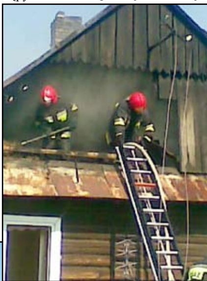
Po ugaszeniu pożaru strażacy przystąpili...
