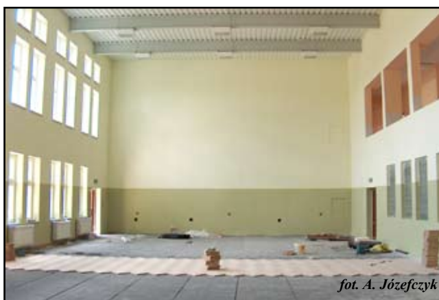
Nowobudowana sala gimnastyczna w Trześniowie
