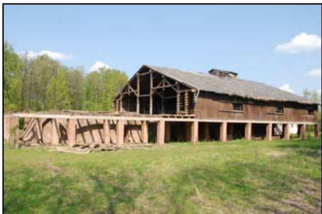
Cegielnia w Haczowie z 1937 r. w trakcie rozbiórki
