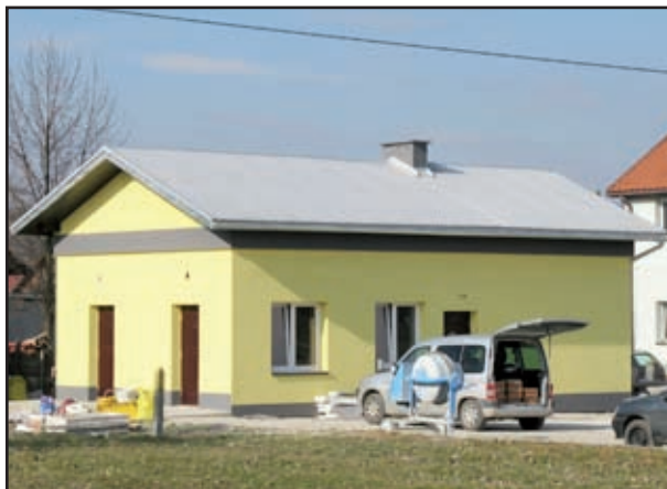
Remont centrum sportowo-kulturalnego
