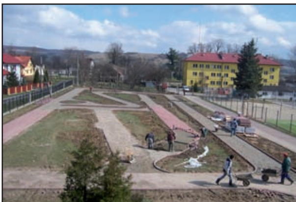
Prace przy budowie miasteczka ruchu drogowego
