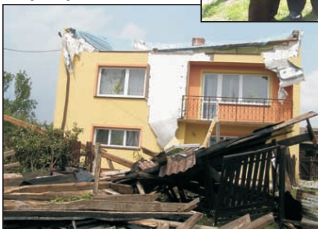
Trąba powietrzna wyrządziła ogromne szkody
