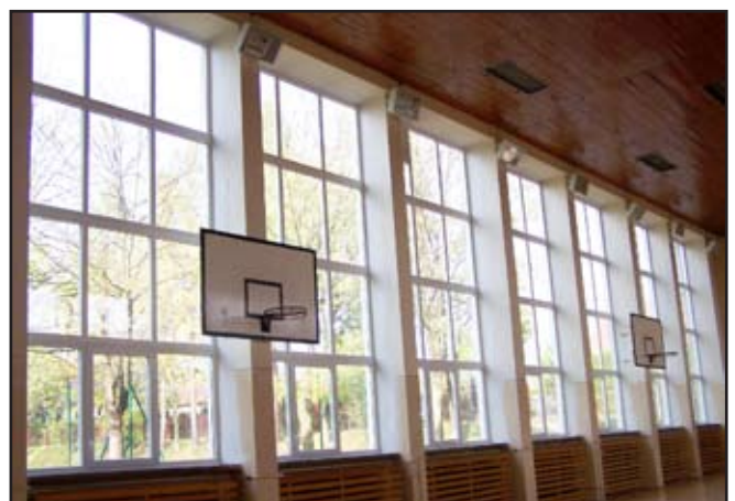
Nowe okna i oświetlenie sali gimnastycznej w ZSB
