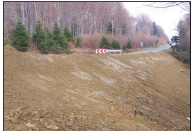
Zlikwidowane osuwisko na drodze Brzozów - Zmiennica
