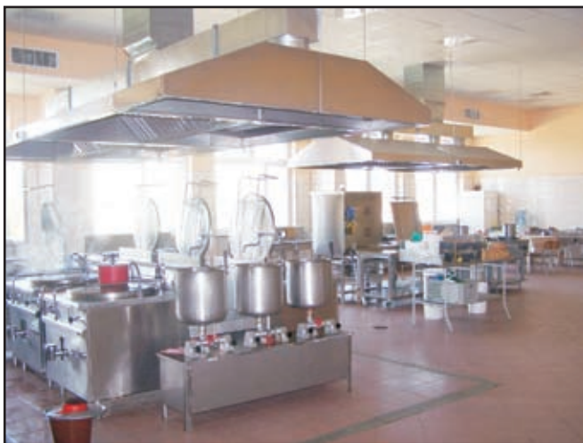
Wyremontowana część kuchni z nowym wyposażeniem
