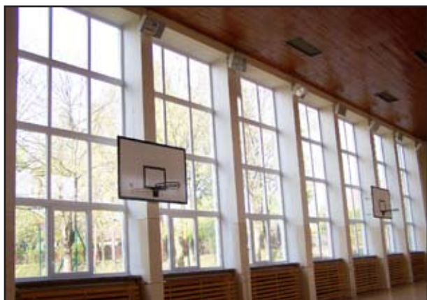
Nowe okna i oświetlenie sali gimnastycznej w ZSB
