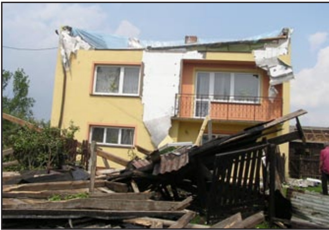
Jeden ze zniszczonych domów
