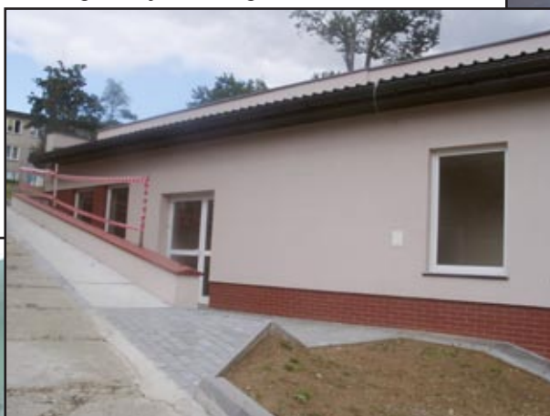
Nowy bunker zakładu radioterapii
