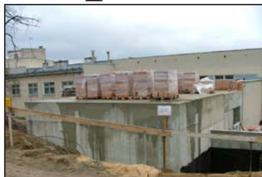
Budowa bunkra do teleradioterapii
