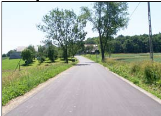
Wyremontowana droga Zmiennica - Jasionów
