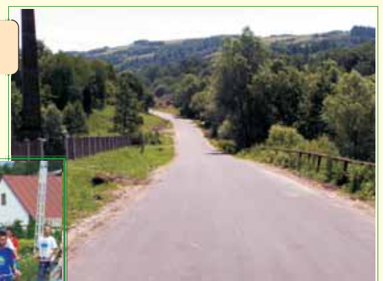
Nowy asfalt na drodze Barycz-Nozdrzec
