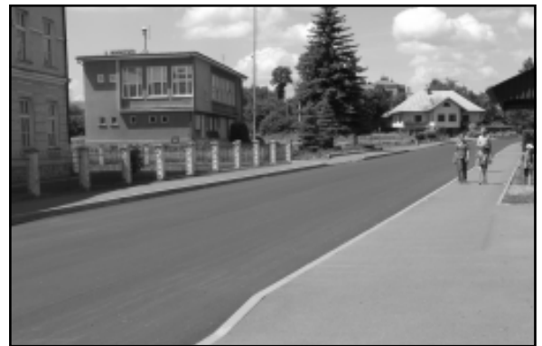
Wyremontowany odcinek drogi powiatowej Iskrzynia - Trześniów
