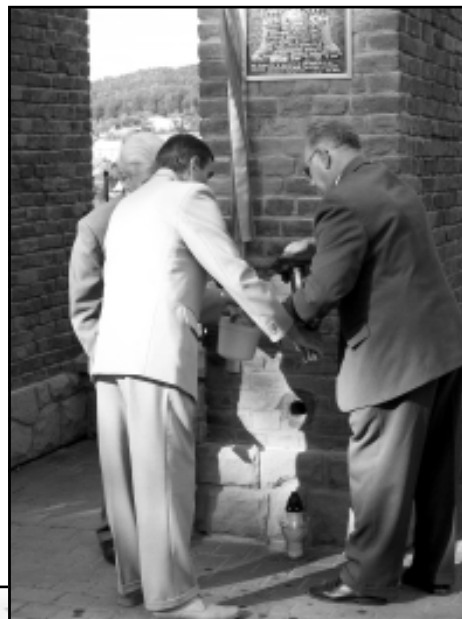
Wmurowanie aktu fundacyjnego
