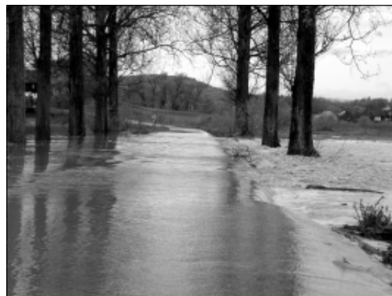
Zalana droga w Bliznem
